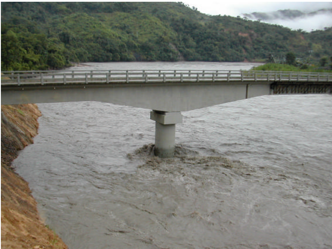
Foto 2 : Puente de Guanay, donde se podría instalar una estación ?
