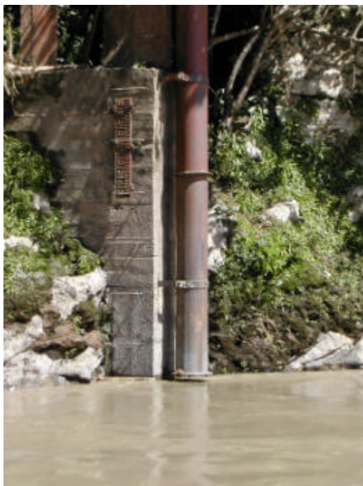
Figura 9 : Tubo del limnígrafo y escala de Angosto del Bala
