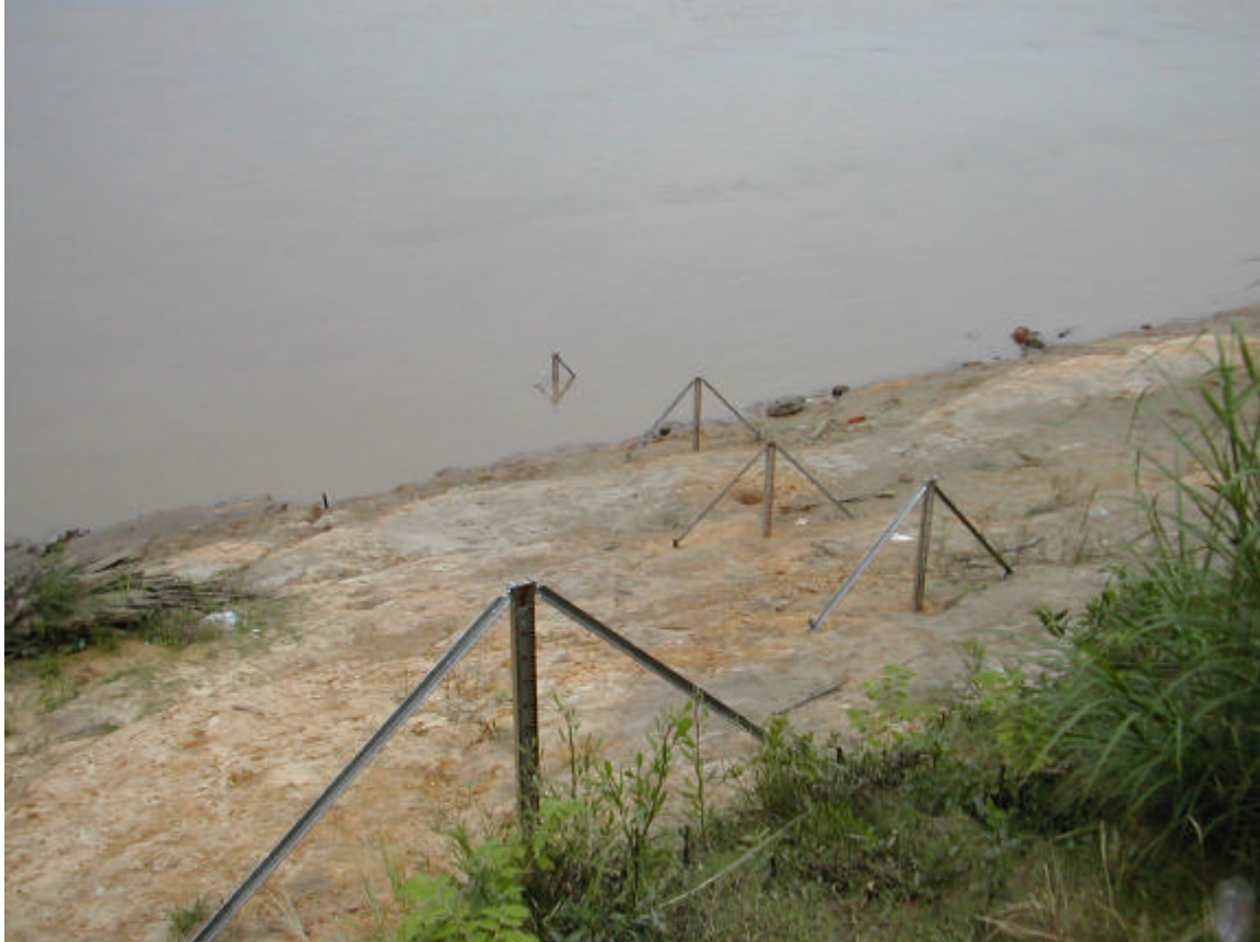
Escalas de Riberalta: elementos bajos instalados de nuevo
