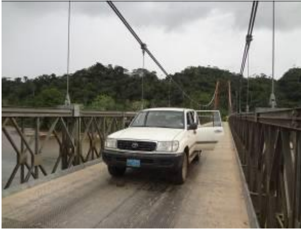
Foto 1. La camioneta cruzando el Puente Nieva
