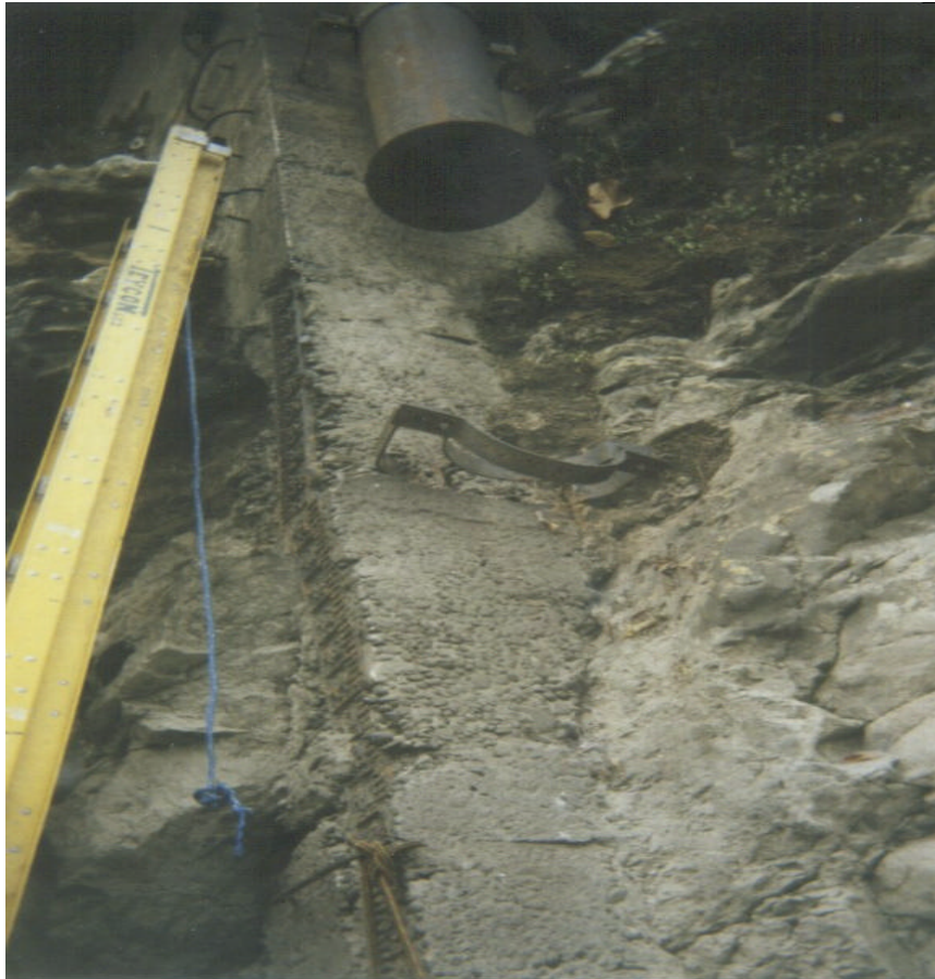
Figura 2 : Tubo antes de la instalación
