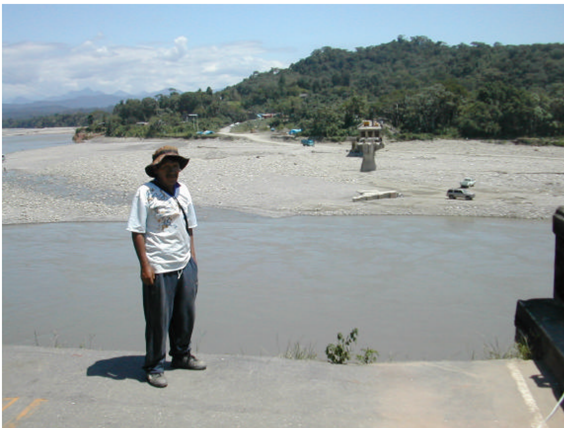
Villa Tunari : vista del puente destruido por el agua.
