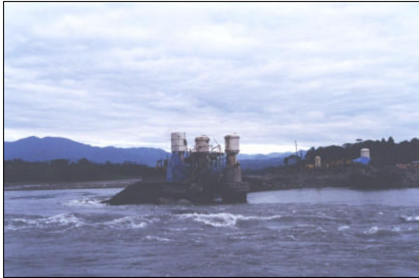
Obras sobre el Rio Chaparé
