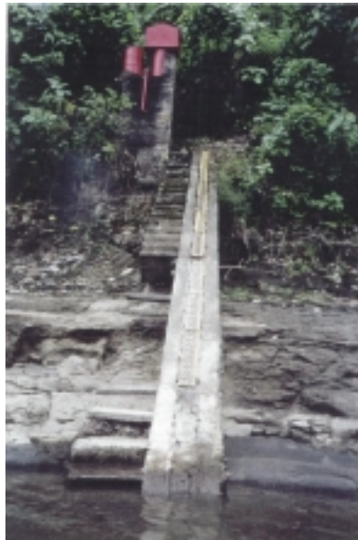
Foto 1. Estacion limnimetrica de Esmeralda D.J.Sade
