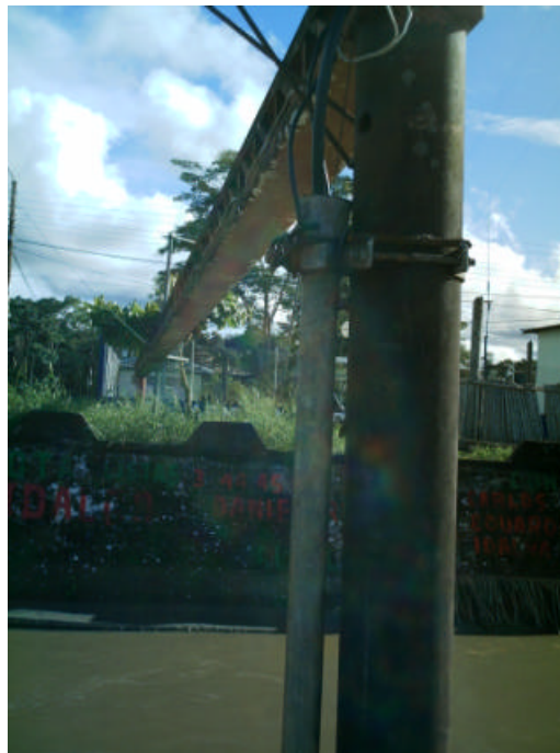
Foto 1: Reinstalación del Orphimede en Nuevo Rocafuerte).
