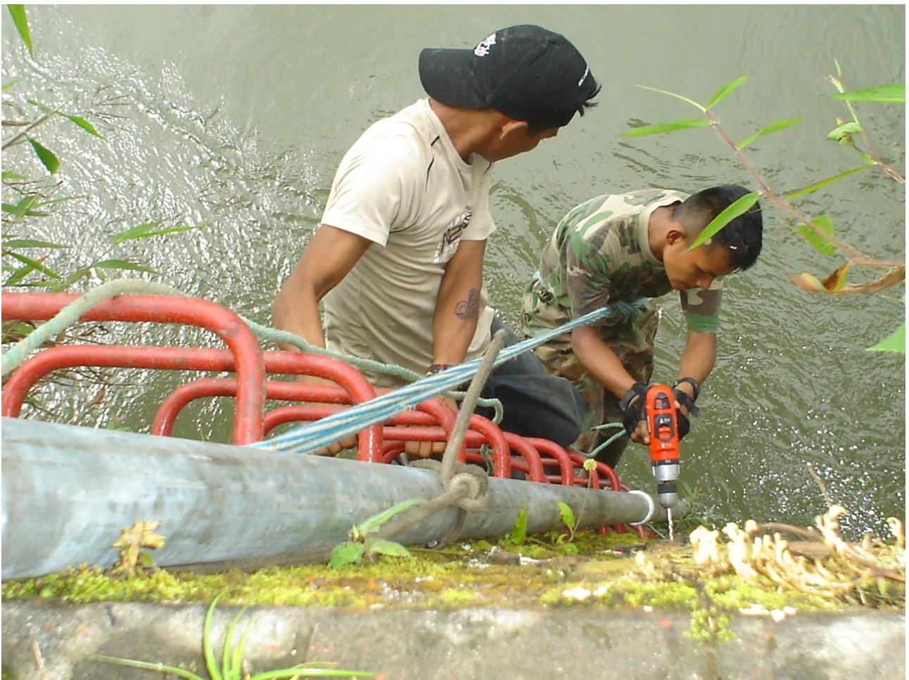
Foto 1: ORPHIMEDES instalado sobre el río JATUNYACU
