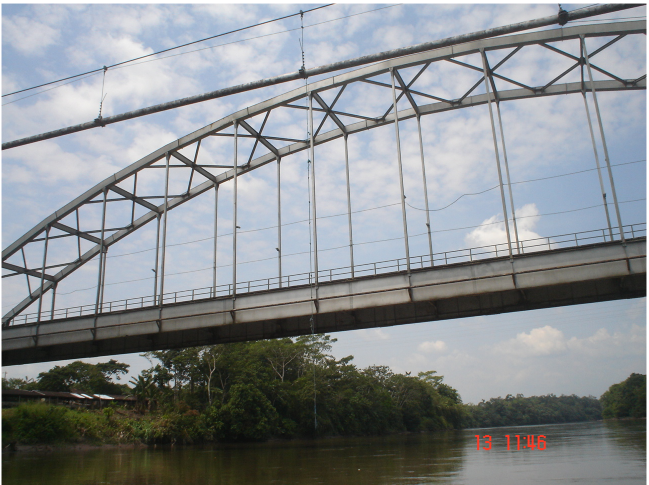
Foto 1: Puente sobre el río Coca sector San Sebastián
