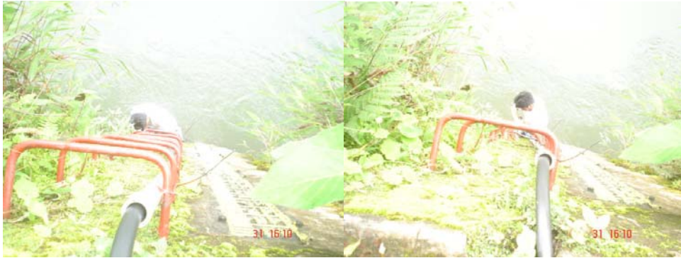
Fotos 1 y 2 Revisión tubería que contiene la cámara de burbujeo.
