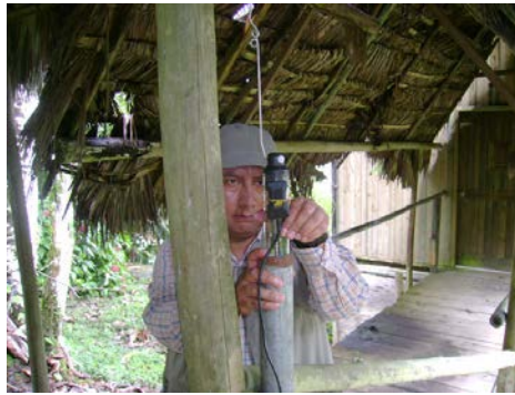
Foto: Instalación del nuevo Orphimedes
