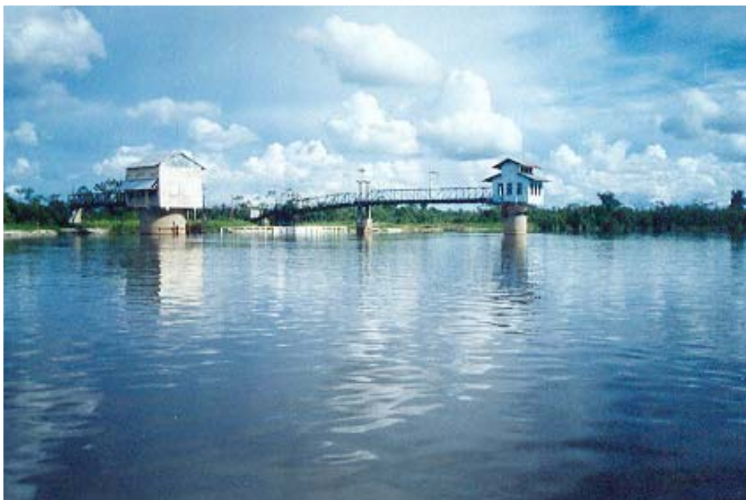
Foto 1. Estación Seda Loreto ubicada en la Bocatoma de SEDA Loreto sobre el río Nanay.
