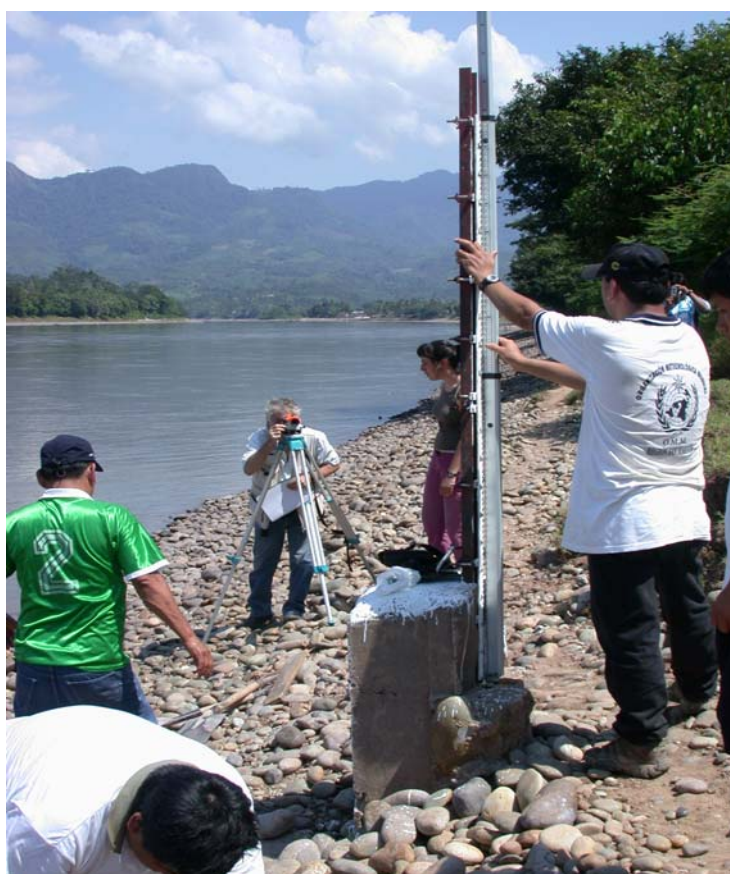
Foto 1: Instalación de reglas a Chazuta
