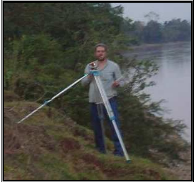
Foto N° 2: Nivelación de Reglas Chazuta
