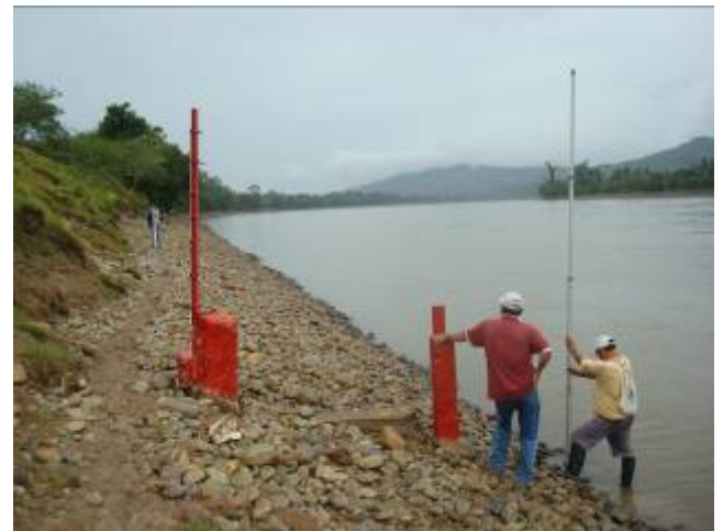
Foto N° 10: Realizando nivelación diferencial en la H. Chazuta río Huallaga
