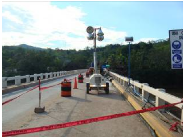
Foto N° 13: Trabajos de rehabilitación en puente Bolivia (cruza el río Mayo)
