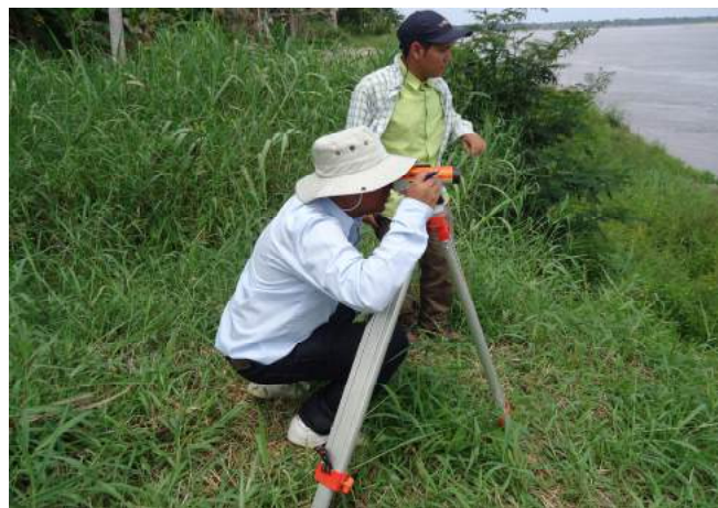
Foto N° 8: Nivelando la H. Genaro Herrera
