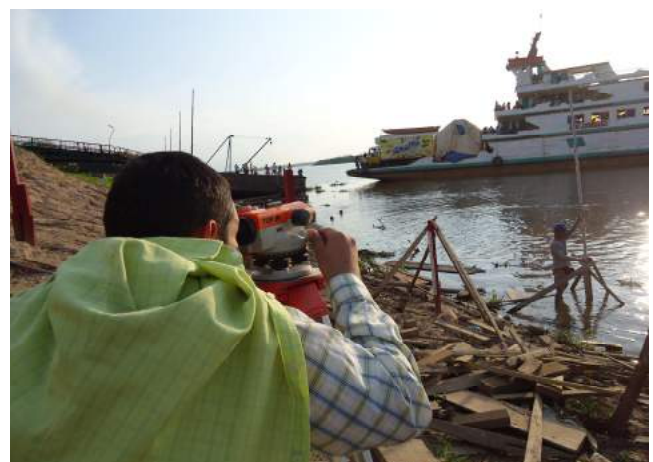
Foto N° 10: Nivelando la H. Requena
