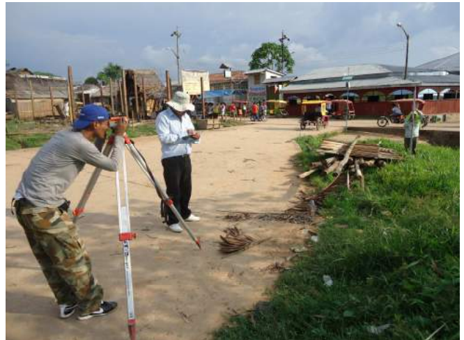
Foto N° 14: Nivelando en Requena
