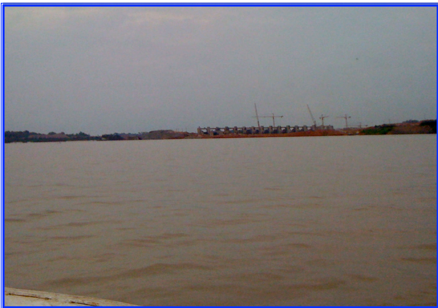
Les travaux de construction du barrage de Santo Antônio sur le Rio Madeira en amont du point de prélèvement ORE de Porto Velho
