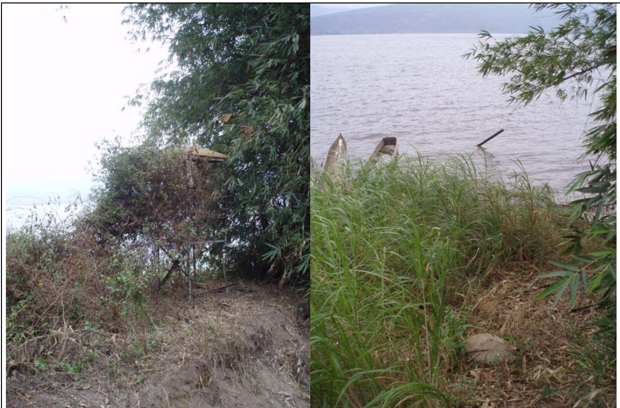
Photo 2) Station de Maluku Trechot sur le Congo : à gauche : tour de la balise Météosat; à droite : état des supports des règles limnimétriques disparues
